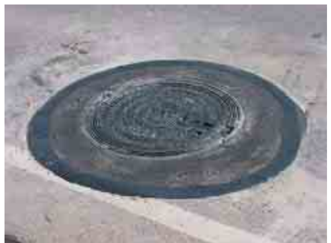
fertiger Einbau nach ca. 45 Minuten später
