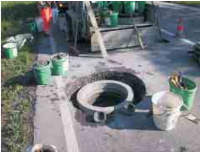
Adapterring ausrichten und vollflächig in EBRALIT ® eingießen
