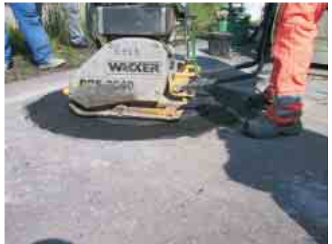
Abdeckung einrütteln EBRALIT ® ist bereits voll belastbar
