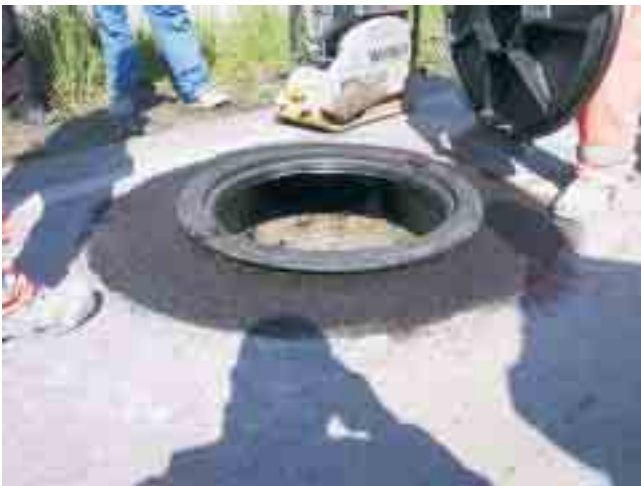
Rahmen der Abdeckung einsetzen
