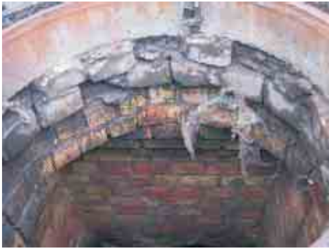
defekter Schachtunterbau ...
