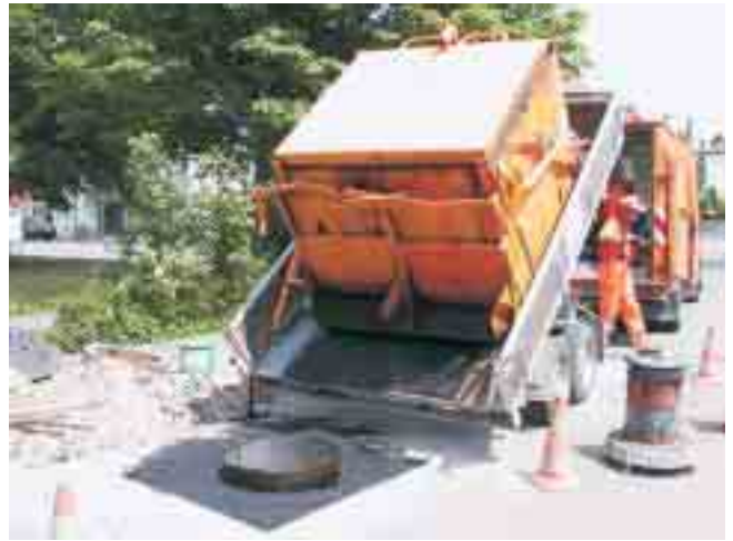
Heißasphalt aus unseren Thermobehältern
