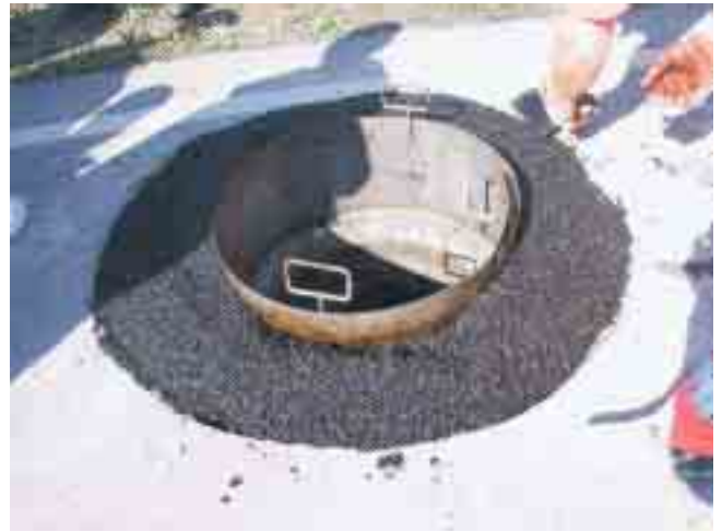
Fertigbitumen mit Asphaltchalung
