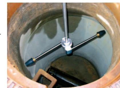
Pulizia tramite ugelli rotanti ad alta pressione
