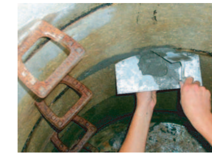
Riempimento di scheggiature con BECK IPANEX
