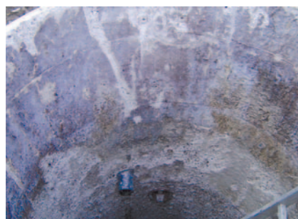
Corrosione interna
