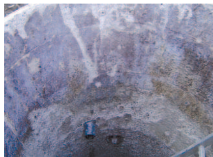
Corrosione interna
