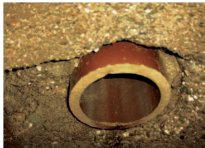
Allacciamento del tubo anermetico
