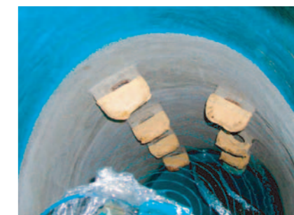
Nebulizzazione di BECK PUR con il sistema centrifugo
