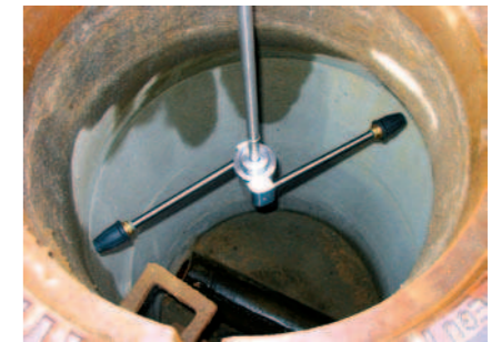
Pulizia tramite ugelli rotanti ad alta pressione
