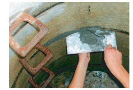
Auffüllen von Ausbrüchen und Fehlstellen mit BECK IPANEX
