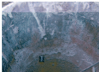
Betonkorrosion
