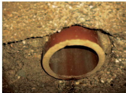
Undichte Rohreinbindung
