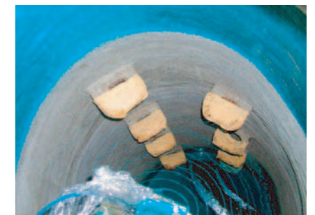
Sprühen von BECK PUR im Anschleuderverfahren
