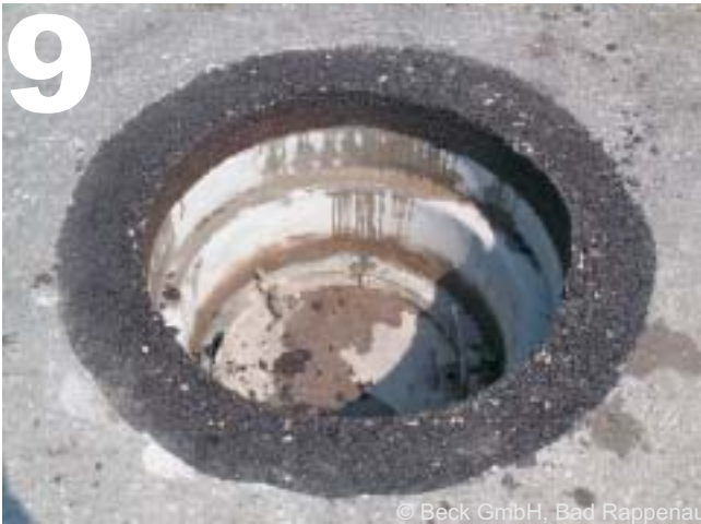
Einbauschalung entfernen
