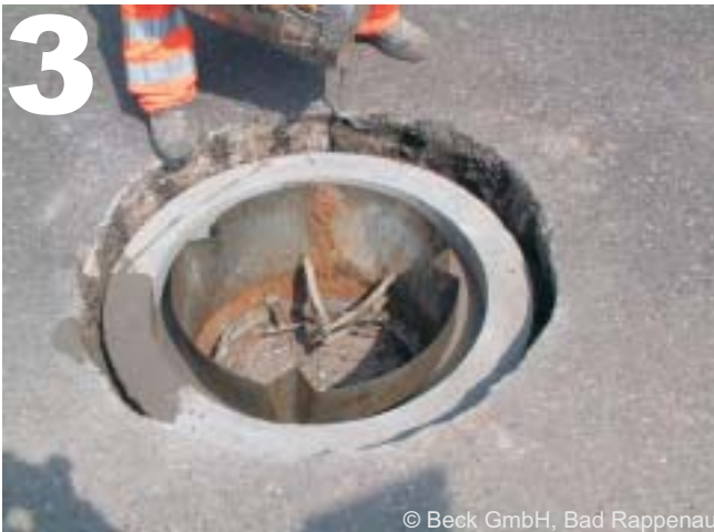
3 Schalung einsetzen und mit Ebralit vergiessen
