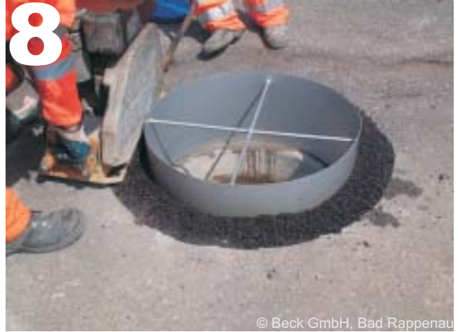
Asphalt vorverdichten
