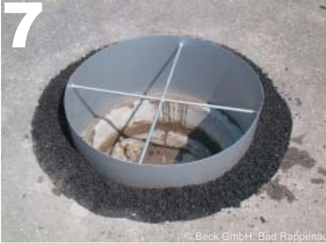
Arbeitsraum mit Asphalt auffüllen
