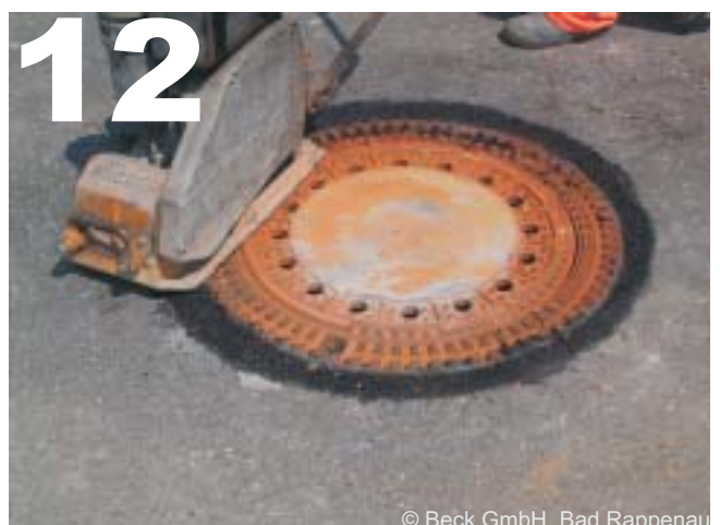
Schachtabdeckung auf Fahrbahnneivau einrütteln
