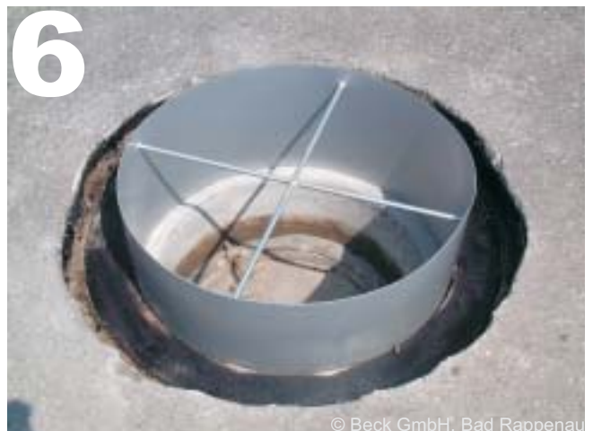
6 Einbauschalung einsetzen
