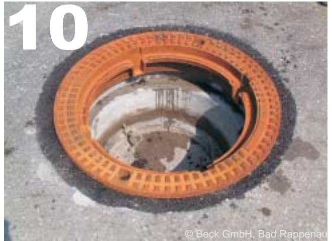
Schachtrahmen einsetzen
