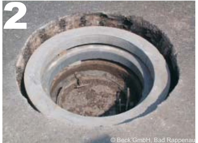
2 Ausgleichsringe und Adapterring ausrichten
