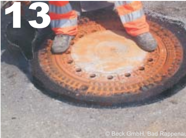
Nahtverguß mit Heißbitumen
