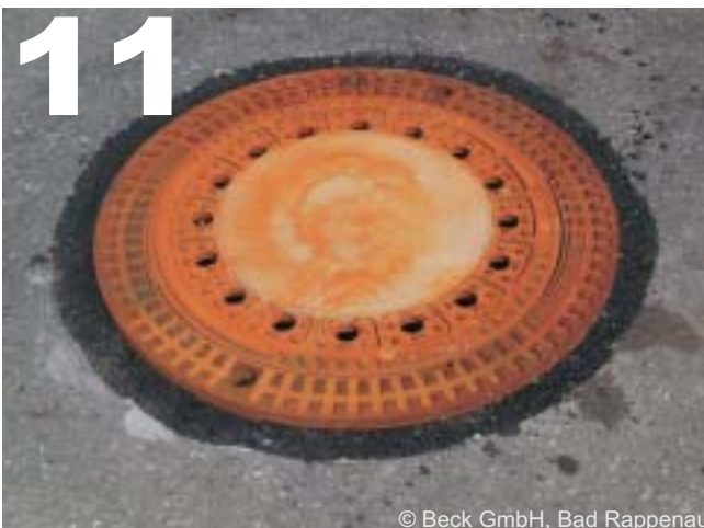
Schachtrahmen mit Deckel verschließen
