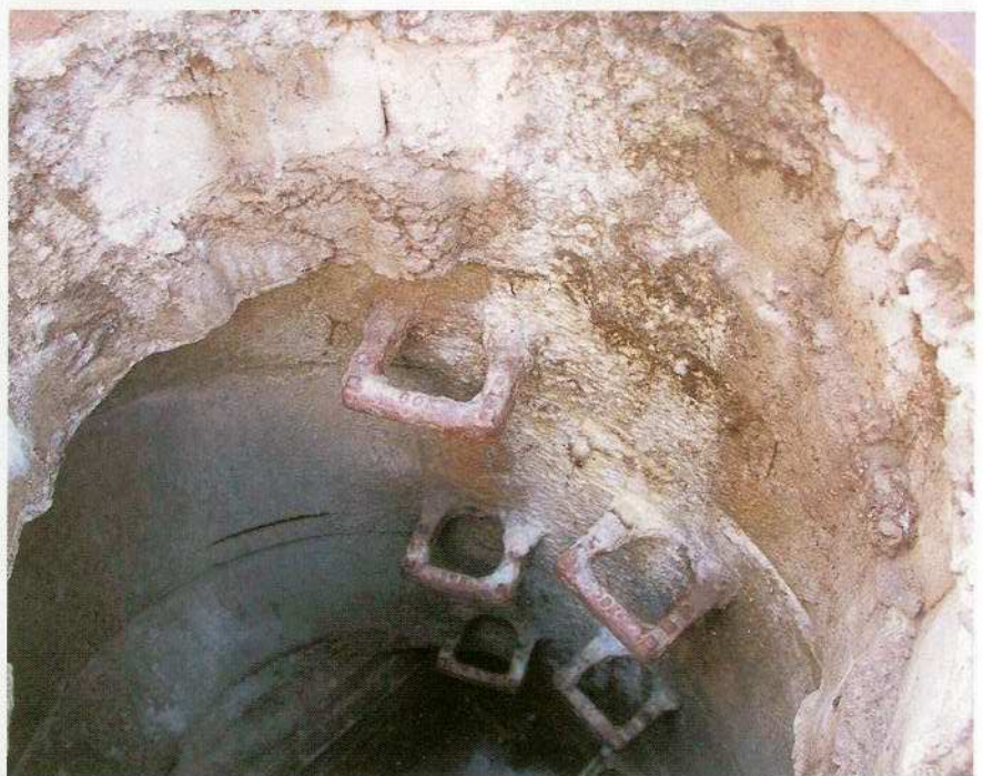
Abbildung 7: Schachtsanierung vorher
