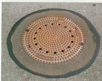
Abbildung 4: Perfekt regulierter Schacht mit Bituplan-Abdeckung
