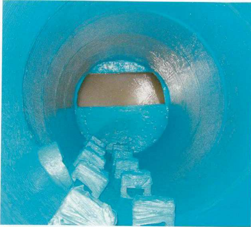
Abbildung 8: Schachtsanierung nachher
