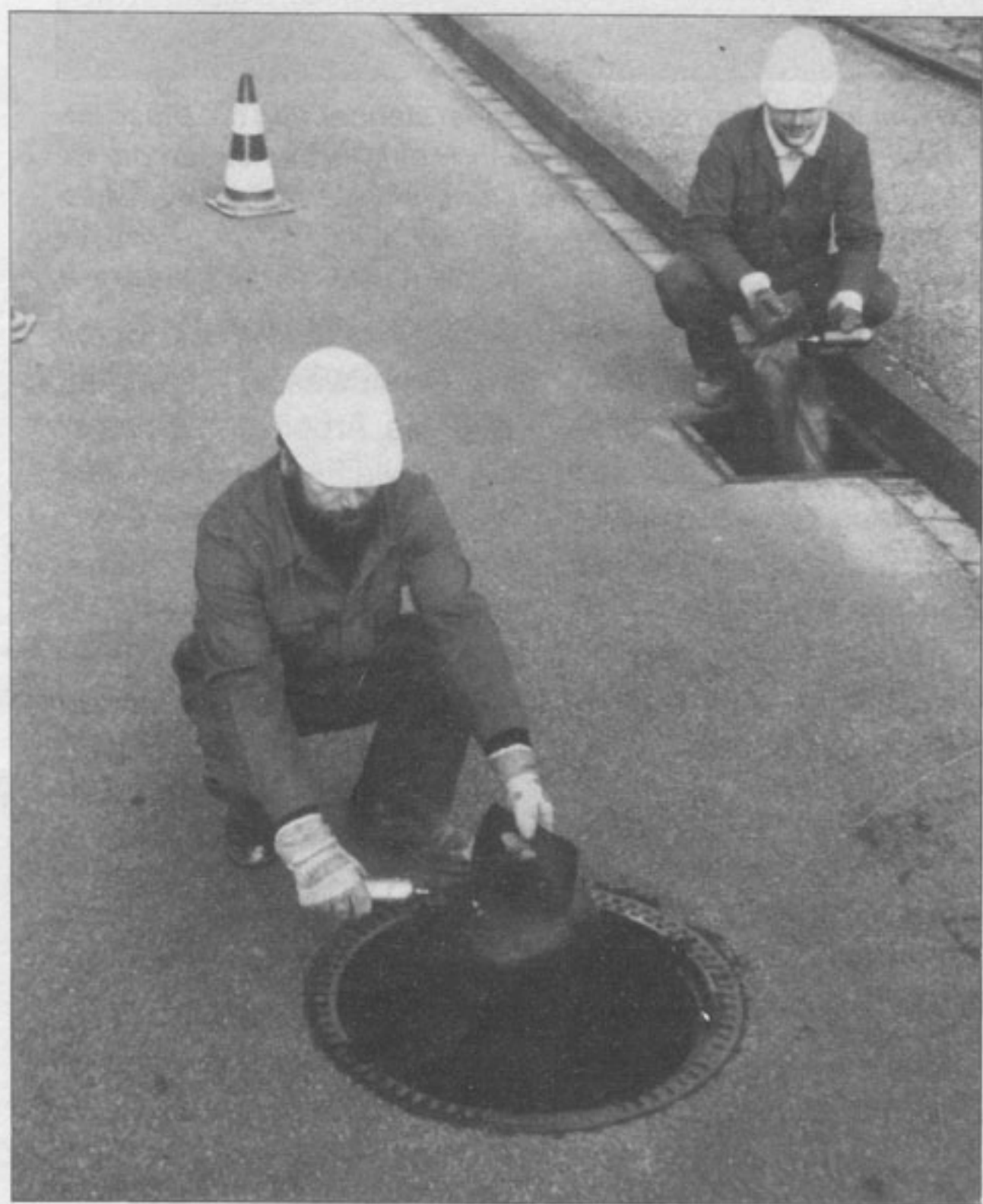
Bild 2: Demonstration des Einsatzes der Blase an einem Regenlauf und an einem Kanalschacht: Die Blase wird zu zwei Dritteln in den Schacht gesenkt und dann mittels der Druckluftkapsel aufgeblasen.
