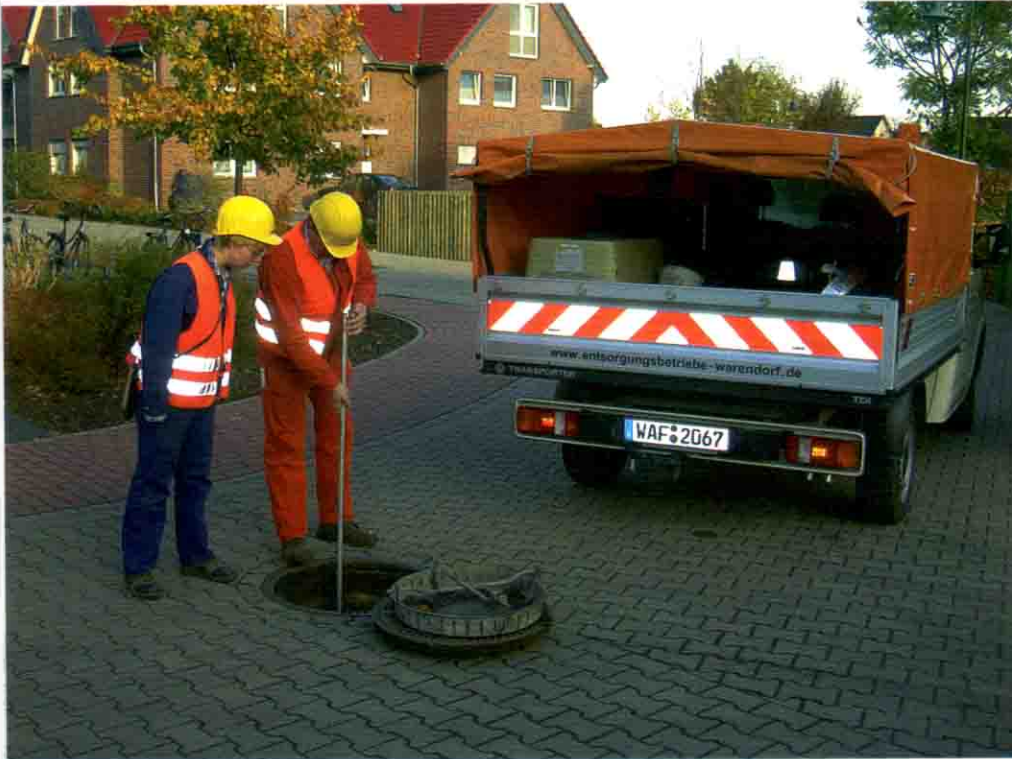
Mitarbeiter bei der Kanalspiegelung
