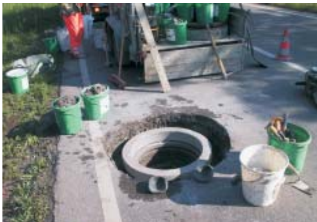
Adapterring ausrichten und vollflächig in EBRALIT® eingießen
