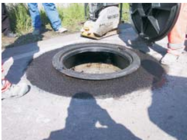
Rahmen der Abdeckung einsetzen
