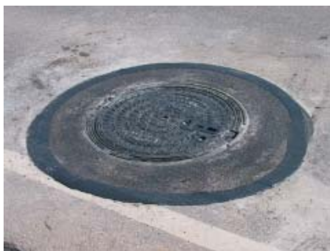
fertiger Einbau nach ca. 45 Minuten später
