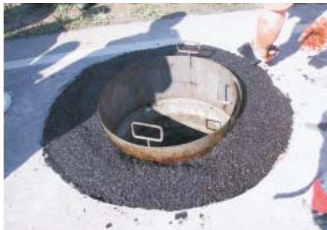
Fertigbitumen mit Asphaltchalung
