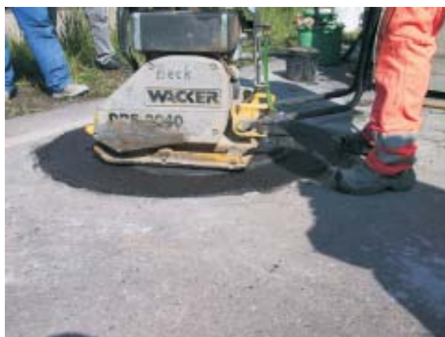
Abdeckung einrütteln EBRALIT® ist bereits voll belastbar
