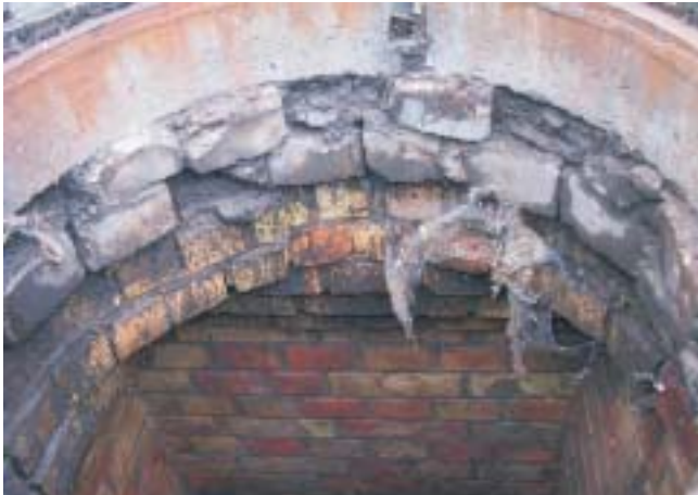
defekter Schachtunterbau ...
